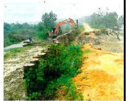
JENTERA JPS menanam cerucuk batang kelapa bagi menahan ban daripada rebak akibat air pasang besar di Sabak Bernam semalam.
